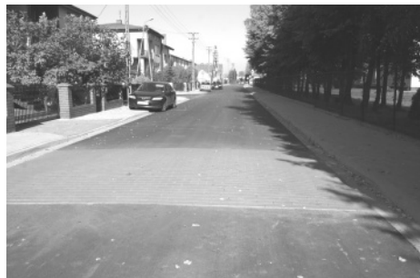
Wyremontowany odcinek ul. Jagiellońskiej we Władysławowie
