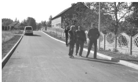
Nowa droga przy ul. Chrobrego we Władysławowie
